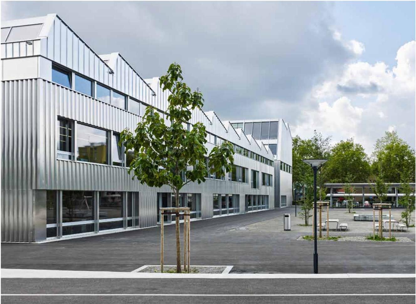
Der Bau von Sheddächern in Massivbauweise, wärmedämmend verkleidet mit einer Glas-Metallhülle, sowie grossflächige Sichtbetonarbeiten sind auch für eine erfahrene Baumanagementfirma keine alltäglichen Aufgaben – und ein Allzweckplatz mit Spielfeld auf dem Dach einer Sporthalle ist absolut aussergewöhnlich. Realisiert wurden sie beim neuen Schulhaus von Schlieren.
